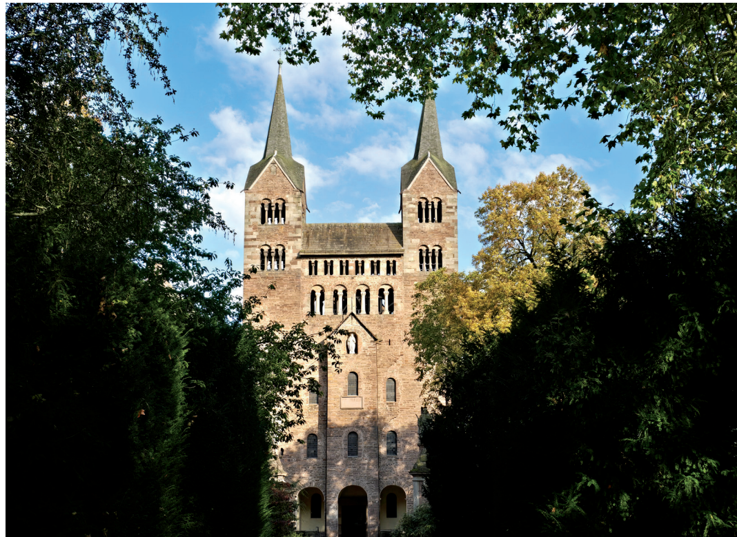
Die Doppelturmfassade des Westwerks ist das Gesicht der Welterbestätte. Kirche und Westwerk sind flankierend zur Paderborner Ausstellung an zwölf Sonntagen vom 10. November 2024 bis 26. Januar 2025 jeweils von 10 bis 14 Uhr geöffnet. Foto: Kirchengemeinde Corvey
