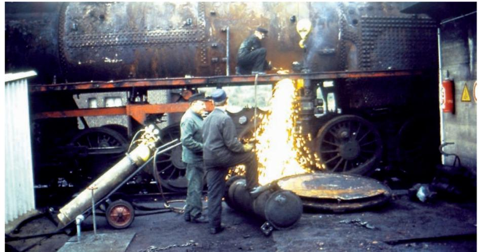
1976 war Schluss, die Dampflokomotiven wurden durch Dieselfahrzeuge ersetzt und die Schlosser mussten die Lokomotiven mit Schweißbrennern zerlegen. Foto: H. Heinemann
